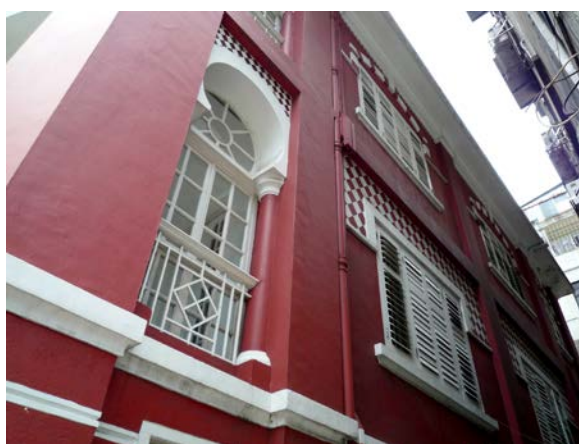
圖 4.5.6：東望洋斜巷 6 號房屋側立面。
