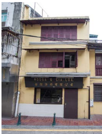
圖 6.5.6：龍嵩正街 45 號房屋現況。
